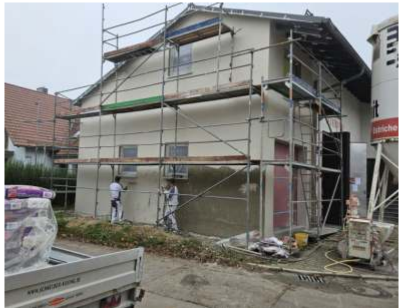
Verputzarbeiten am Anbau
